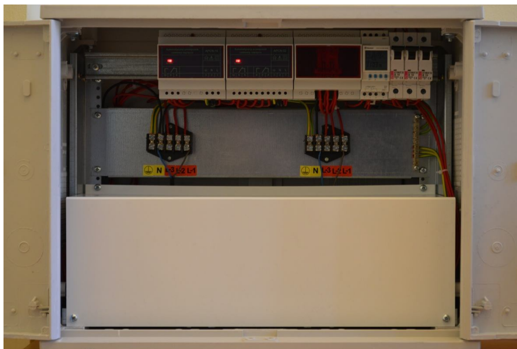
Widok wnętrza automatycznego reduktora zużycia energii typu ARZE3.T-16
